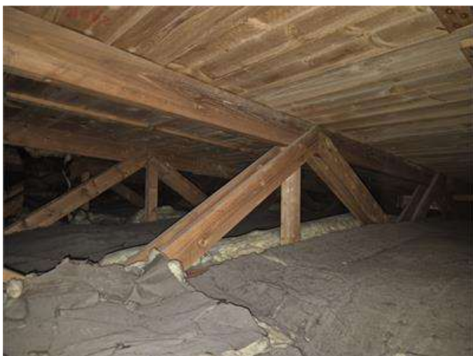
Bild från vindsutrymmet.
